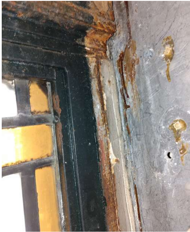
Traverse en remplacement Ébrasement en marbre fragile à laisser en place
