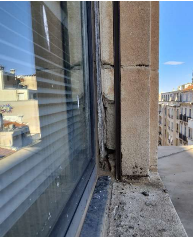
Présence de rail Cas exceptionnel de dégradation
