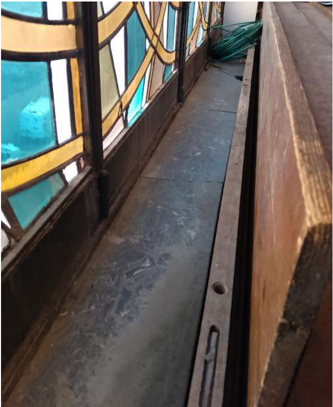
Déformation des baguettes de plomb
